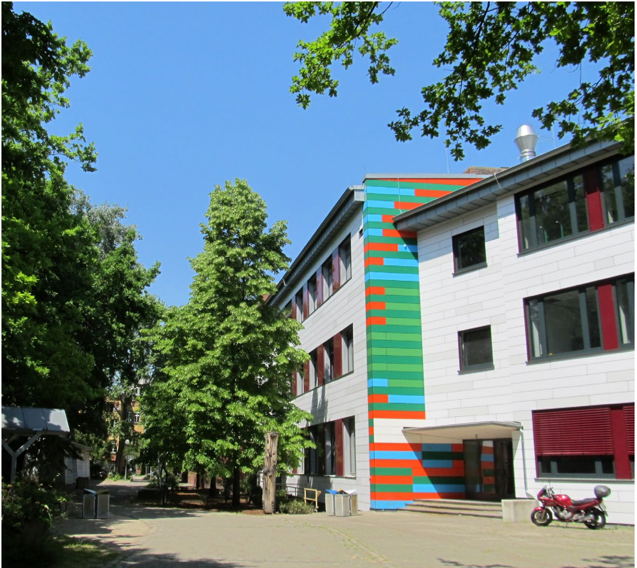
Fassade, Hans-Böckler-Schule in Berlin Fasadengestaltung: Christian Roeckenschuss Alten Architekten, Berlin, 2010 Foto: Hans-Böckler-Schule,
