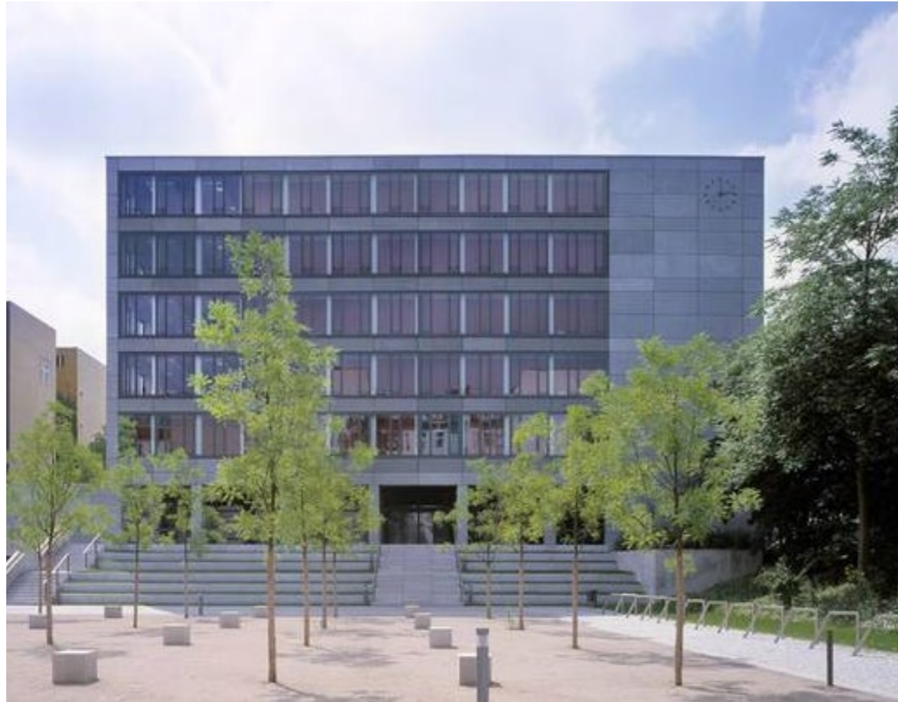
Oberstufenzentrum Recht, Berlin, 2005, Außenansicht Turkali Architekten, Foto: Christian Eblenkamp
